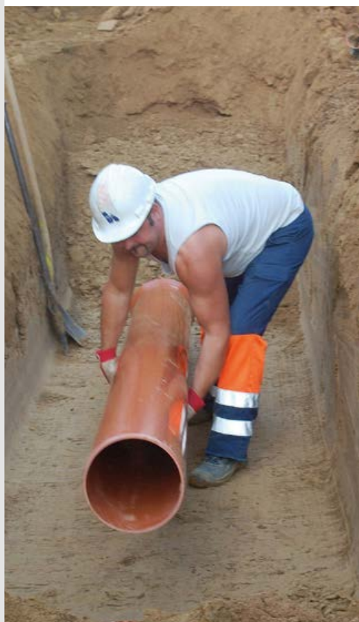
De lichte kunststofbuizen hebben ook ergonomische voordelen.
