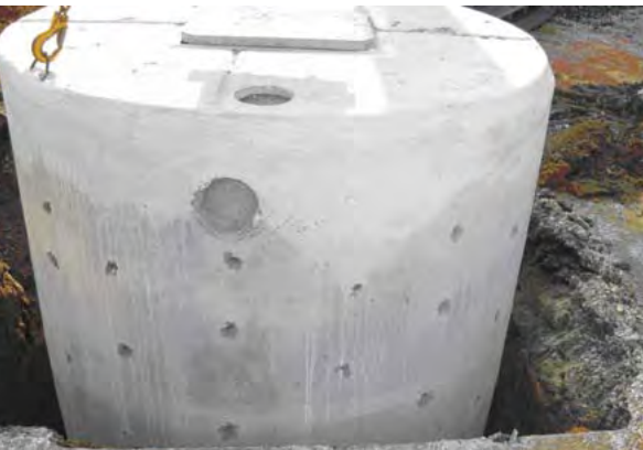
Betonnen infiltratieput
