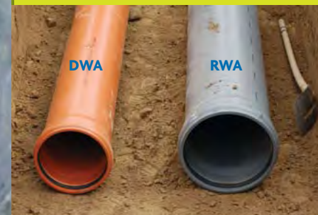
'Gescheiden afvoer van afval- (bruin) en regenwater (grijs)'
