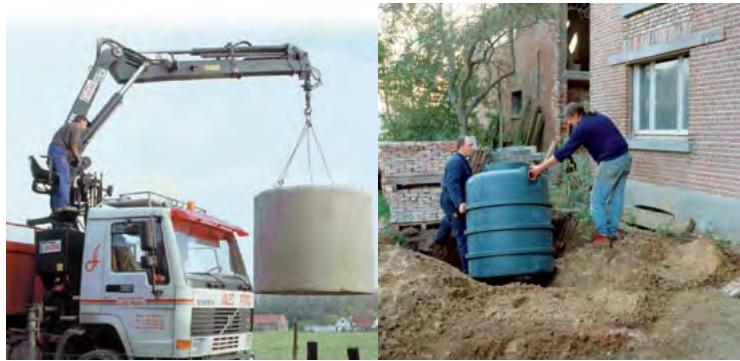
Plaatsing betonnen en kunststof regenwaterput
