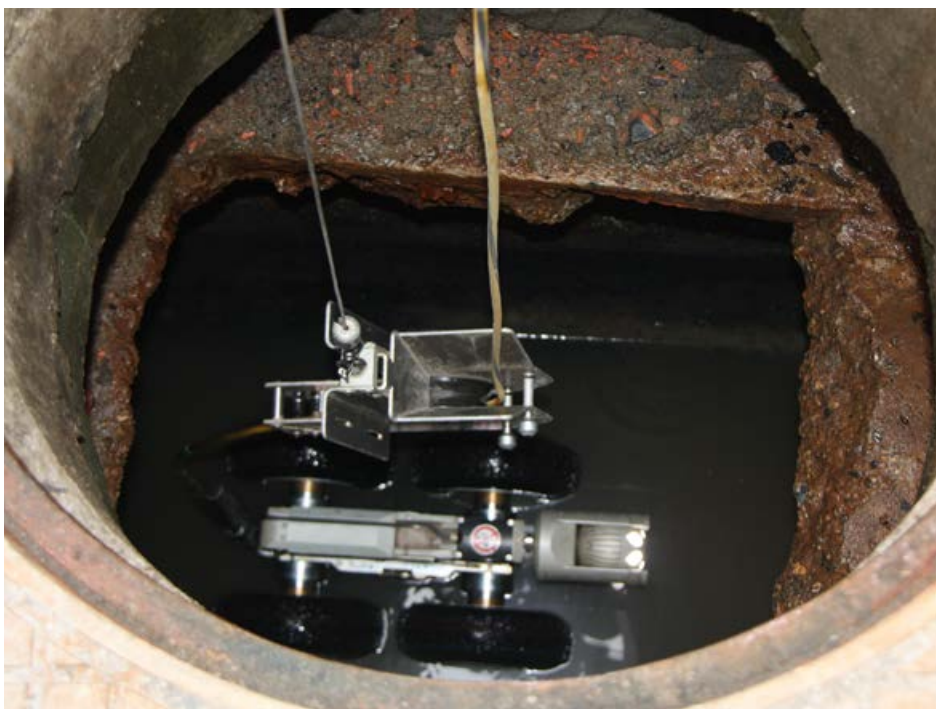
Camera-inspectie in Diest (Foto Aquafin)
