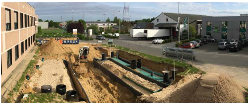
Infiltratieproeven die recent werden uitgevoerd.
